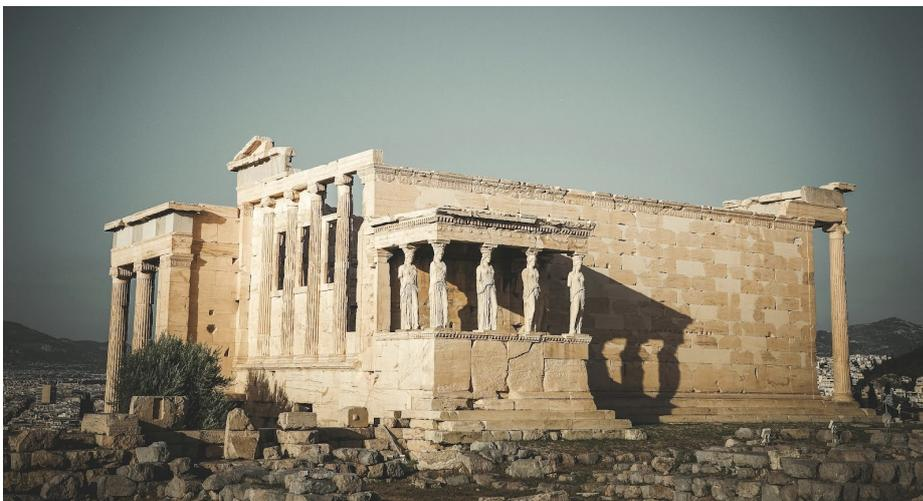
quando l' architetto Nikolaos Balanos intraprese operazioni di consolidamento utilizzando materiali inappropriati, come il cemento armato, che causarono ulteriori danni alle strutture originali.
